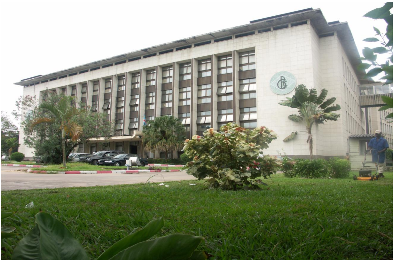
BANQUE CENTRALE DU CONGO, Siège de Kinshasa
